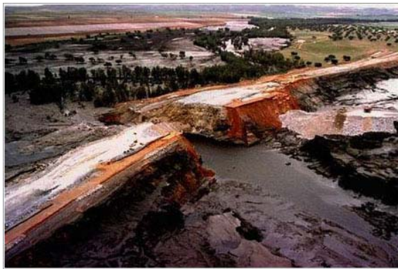
Desastre de Aznalcóllar: rotura de una balsa de residuos de la mina de pirita en 1998 http://eco.microservos.com
